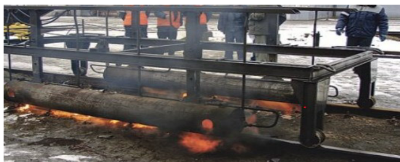
Рис. 3. Самодельная металлическая рама с нагревательной установкой «Прибор Зубова»
